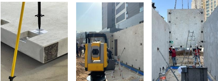
PC벽체 치수 및 수직도 확인
