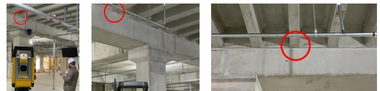
슬래브 설치위치 및 레벨 확인
