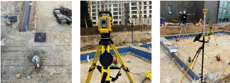
Prism Target 세팅, 앵커 상부 중심점 측정
