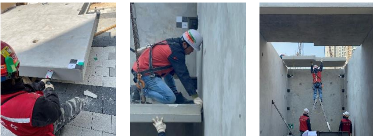
PC계단참 설치위치 및 양단 레벨 확인
