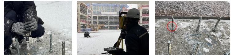
Prism Target 세팅하여 앵커 상부 및 하부 측정
